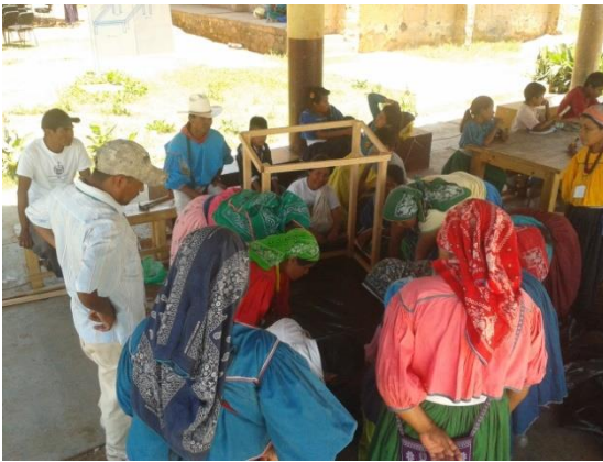
Construcción de deshidratador solar de alimentos
